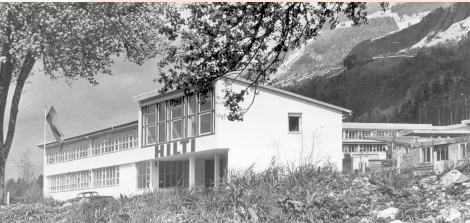
Einer der stark wachsenden Industriebetriebe war die Hilti AG in Schaan. Fabrikgebäude, 1954 Foto: Hilti Aktiengesellschaft
